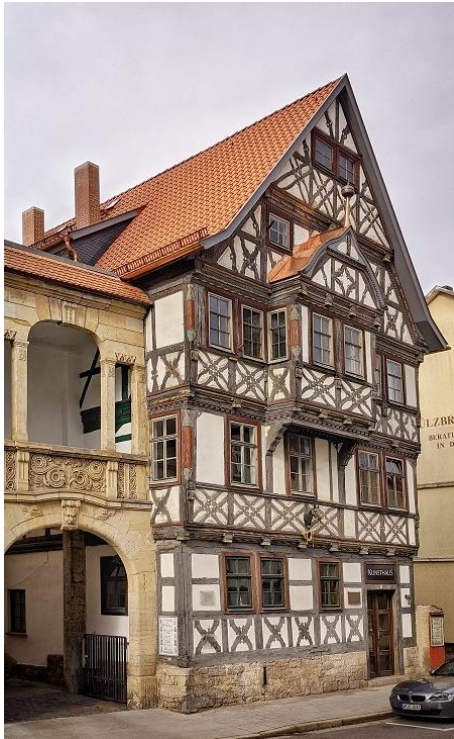
Straßenansicht der Alten Posthalterei nach der Dachsanierung.
