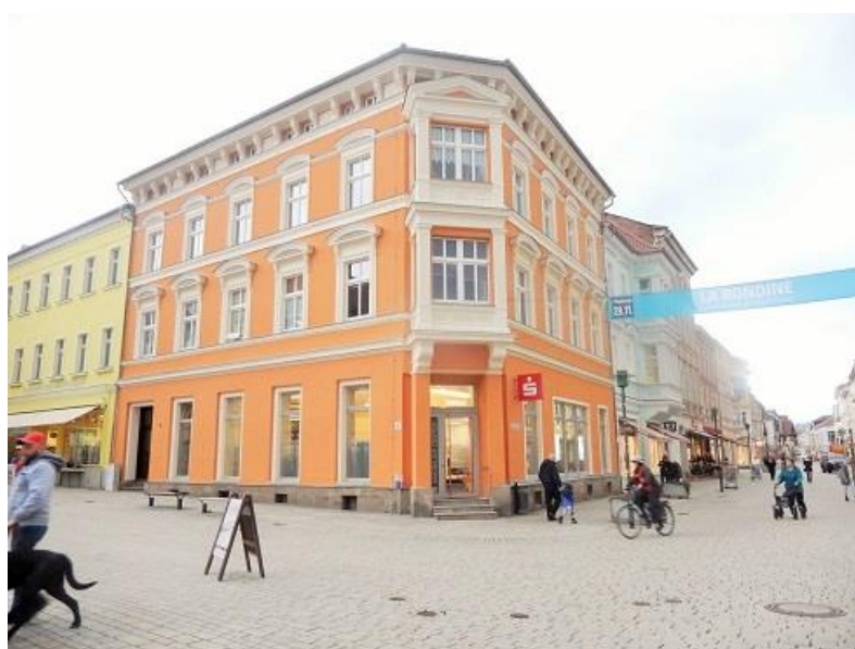
Auch das Eckhaus Markt 5 zeigt sich in neuem „Gewand“ Foto: Meiningen GmbH (Sanierungsbüro)
