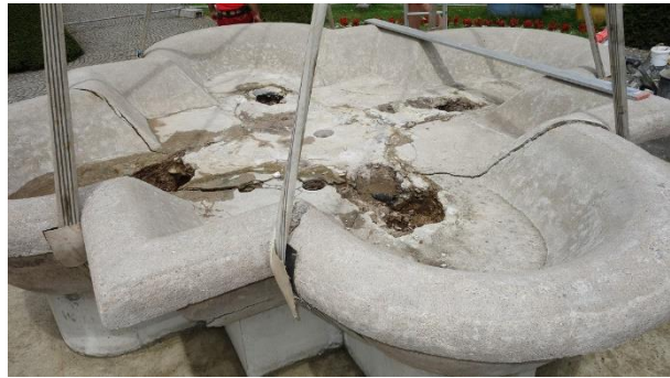
Bei der Wiedermontage zerbrach die alte, restaurierte Brunnenschale (Bild oben). Deshalb musste sie komplett neu angefertigt werden – in zwei Teilen. Im Bild unten: Montage der neuen Schale.
