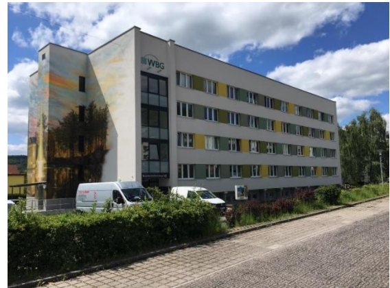
Das Objekt im Baumschulenweg 2 wurde energetisch saniert und 2 Etagen für ambulant betreutes Wohnen umgebaut bzw. modernisiert. Foto: WBG
