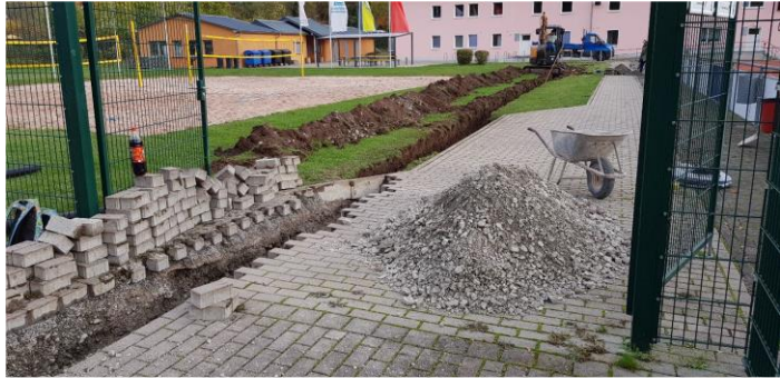
Installationsarbeiten für den Rasenmähroboter
