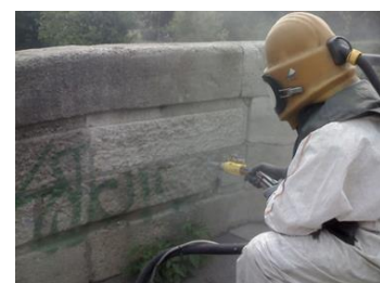
Graffiti-Entfernung durch die KOBEG. Foto: WBG
