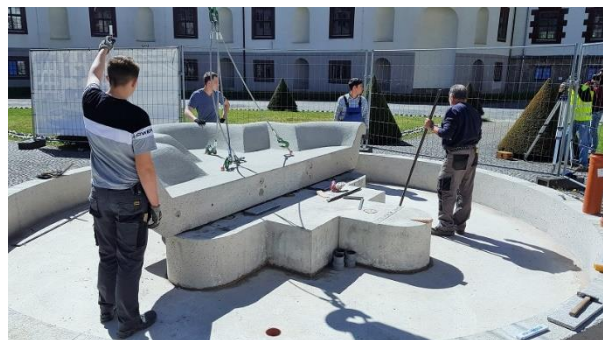
Bei der Wiedermontage zerbrach die alte, restaurierte Brunnenschale (Bild oben). Deshalb musste sie komplett neu angefertigt werden – in zwei Teilen. Im Bild unten: Montage der neuen Schale.
