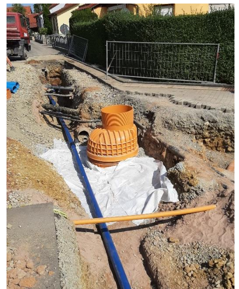
Platzgestaltung „Hinter dem Schloss“, Dreißigacker Foto: Stadtwerke Meiningen GmbH
