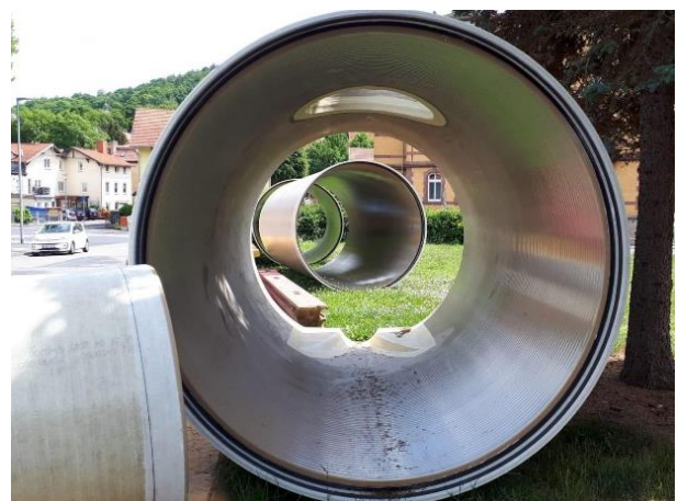
Stauraumkanal-Bauteile, Am Wehr Fotos: Stadtwerke Meiningen GmbH
