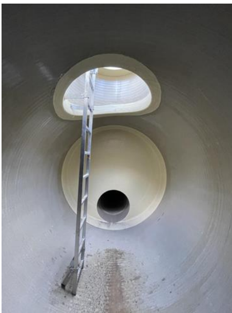
Stauraumkanal-Bauteile, Am Wehr Fotos: Stadtwerke Meiningen GmbH
