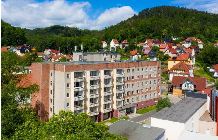
Henneberger Straße 5a (60 Wohnungen)
